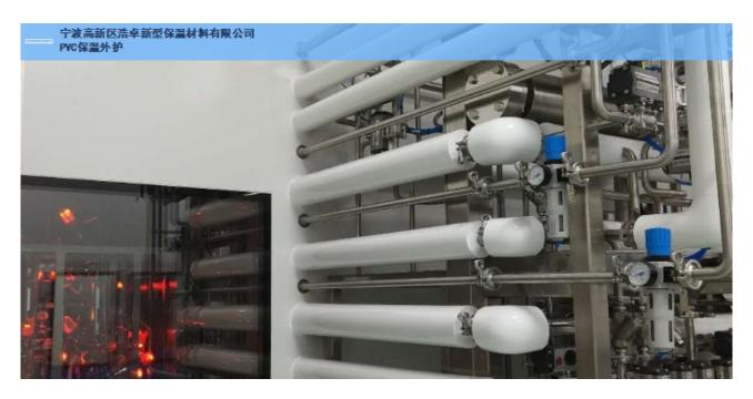
经过这么多年的发展,保温材料的发展已经从开始的石棉、玻璃纤维等到现在的岩棉、橡塑等,这些各自都有自己的特点。要正确的评价一种保温材料的性能,必须要有能够多方面反映保温材料性能的指标。保温材料的性能指标大致有以下几种,导热系数、密度、吸水率、透湿系数、防火性能、吸声系数、抗化学性能、耐老化性、尺寸稳定性等等。而保温外壳可以选择专业的PVC复合保温外壳,从而代替传统的不锈钢或铝皮保温外壳。很大程度的保护管道及设备的保温材料。
